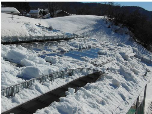
Abbildung 3 Schneerechen beschädigt
