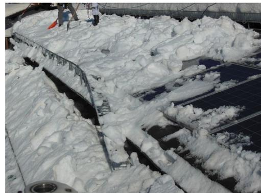
Abbildung 4 Schneerechen beschädigt
