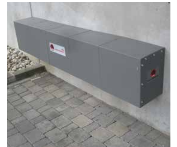
Wetterfeste Abdeckung zur Lagerung der Dammbalken
