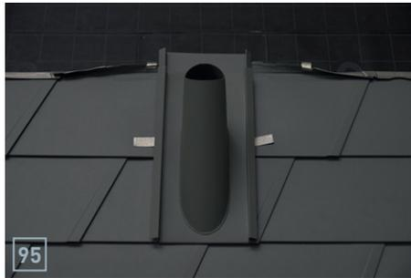
Oben Falz umlegen und Oberkante herunterbiegen sowie nächste Reihen Dachschindeln DS.19 durchdecken.
