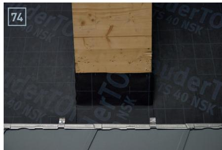
Anzeichnen der Schnitt- und Biegekante in Abhängigkeit der Breite des Seitenteiles (ca. 100 mm).
