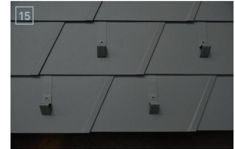
Laut ÖNORM B 3418 ist bei Schneehaltern aus Metall ab einer Dachneigung von 45° eine Kombination mit Schneefangsystemen auszuführen (= PREFA Schneerechenanlage oder Schneerechenanlange an der Traufe).
