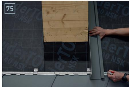
Decken Sie die PREFA Dachschindel DS.19 und beschneiden Sie diese in Abhängigkeit der Breite der Seitenteile (ca. 100 mm) mit 30 mm Zugabe für das spätere Hochstellen der Dachschindel DS.19.
