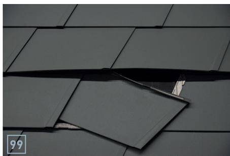
Neue Dachschindel DS.19 einarbeiten und Fälze sorgfältig einpassen.
