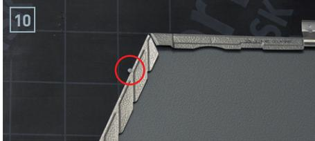
! Die jeweils erste Dachschindel DS.19 ist in jeder Reihe links neben dem schrägen Falz mit einem Nagel zu fixieren, um ein seitliches Verschieben zu verhindern (siehe Abb. 10).
