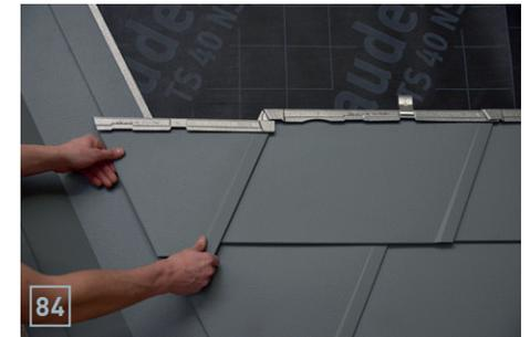
Die angefertigte Dachschindel DS.19 wird beigelegt.
