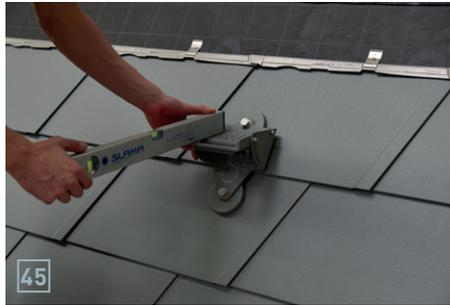
Seitliche Schrauben wieder einschrauben und mittels selbstsichernder Mutter auf die Neigung (Horizontale  $\pm 3^\circ$ ) fixieren.
