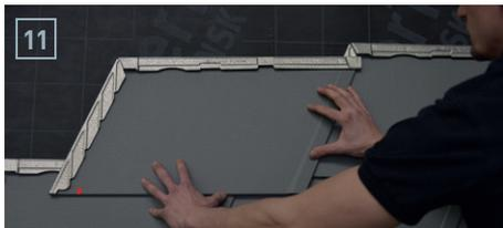
! Die Einkerbung am unteren Schindelumschlag kennzeichnet die Lage des schräg nach unten laufenden Falzes der darauffolgenden Dachschindel DS.19 (siehe Abb. 11).
