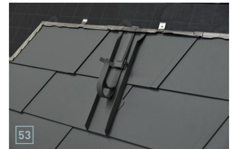
Abdeckkappe durch Falzen des Verschlussstreifens befestigen.
