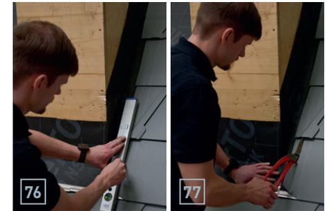
Bereiten Sie die Einfassung (Nacken- und Seitenteil) vor und fixieren Sie diese an den Seitenteilen mittels Retourhaften an der Unterkonstruktion.
