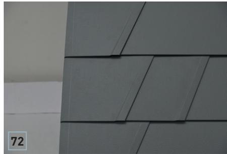
Das Kürzen einer Dachschindel DS.19 ist aufgrund der Kapillarsicken nicht möglich!
