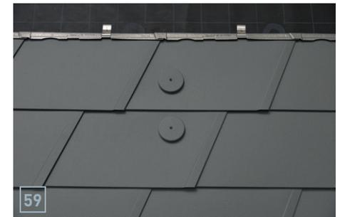
Montage des Sicherheitsdachhakens mittels der beiden Sechskantschrauben (M12) an den Fußteilen (SW19, Drehmoment 35 Nm).
