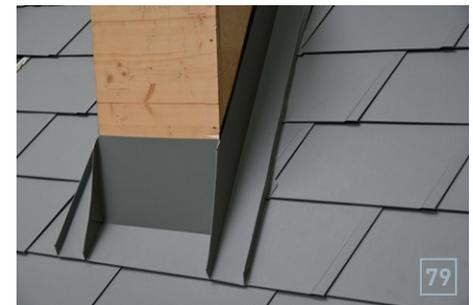
Nackenteil: Legen Sie die senkrechten Fälze der Seitenteile im oberen Bereich um und beschneiden Sie das Nackenteil sowie die Seitenteile mit 30 mm Zugabe. Stellen Sie den Umschlag her – nun kann über der Einfassung die Eindeckung der Dachfläche fortgesetzt werden.
