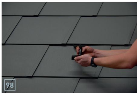
Öffnen Sie den Hafter und entfernen Sie die zu wechselnde Dachschindel DS.19.
