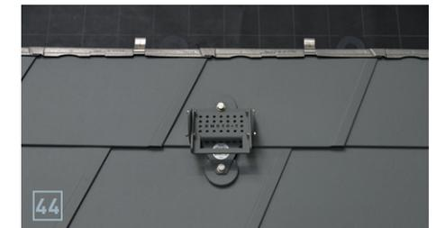
Schrauben und selbstsichernde Mutter zur Einstellung der Neigung lösen und die Trittfläche mittels Wasserwaage justieren. Die Trittfläche so einstellen, dass diese nicht mehr als  $\pm 3^\circ$  von der Horizontale abweicht.
