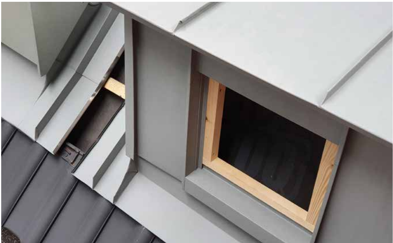
Gaubenfront und -eindeckung in Stehfalz-Ausführung
