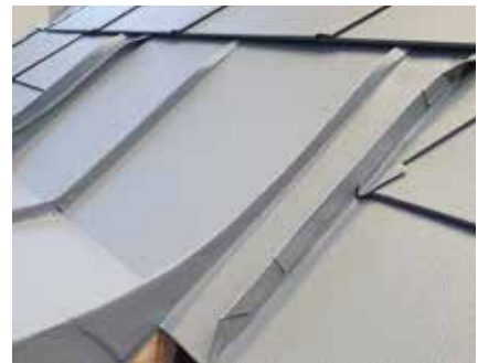
Dachschindel DS.19 Anschluss an Stehfalz
