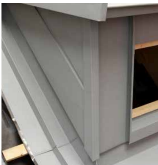
Gaubenbekleidung mit Sidings
