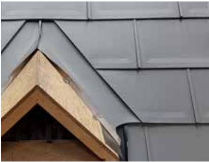
Dachplatte R.16 Kehle, seitlicher Wandanschluss
