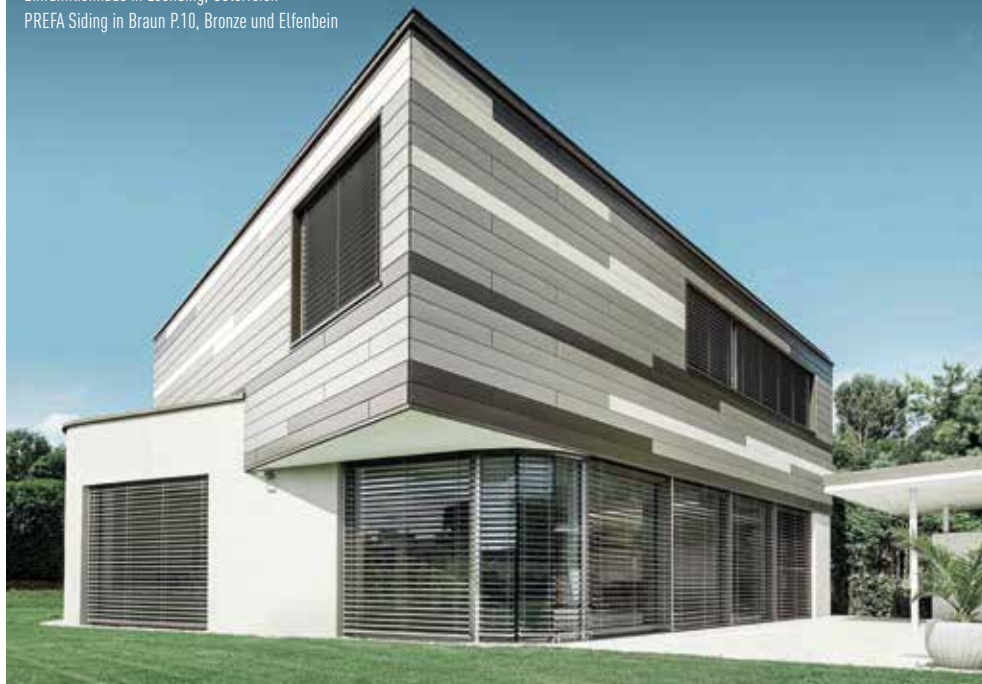
Einfamilienhaus in Leonding, Österreich PREFA Siding in Braun P.10, Bronze und Elfenbein
