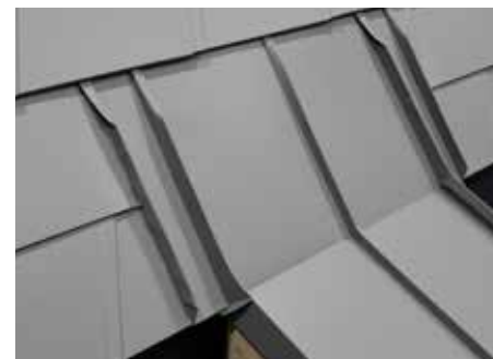
Dachschindel DS.19 Anschluss an Stehfalz
