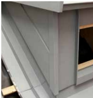
Gaubenbekleidung mit Sidings
