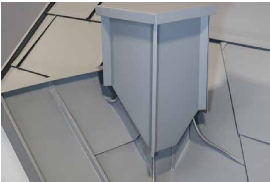
Kamineinfassung in der Kehle
