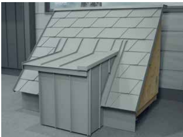
Einbindung Schleppdach ins Hauptdach
