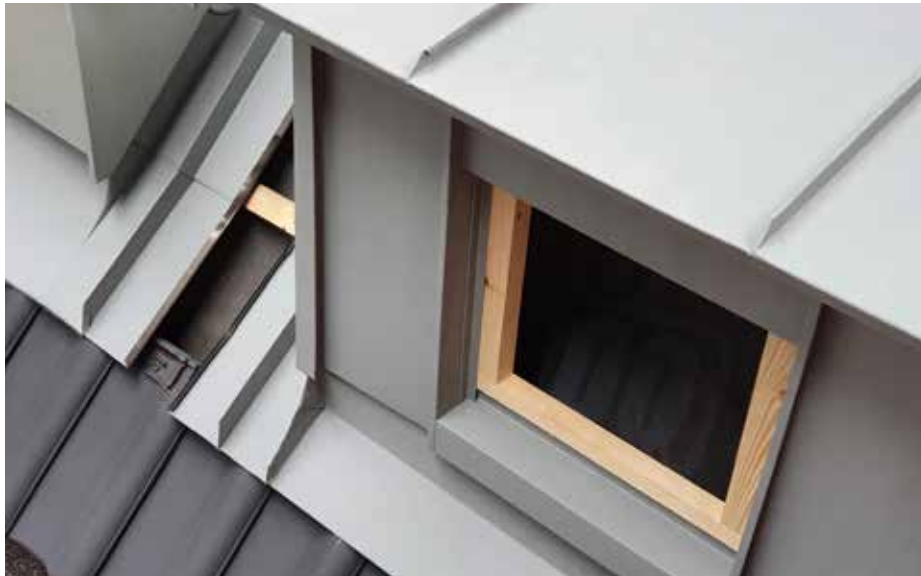
Gaubenfront und -eindeckung in Stehfalz-Ausführung
