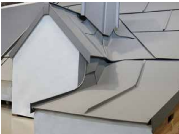
Faltenziehen mit dem Pfanneneckkanter
