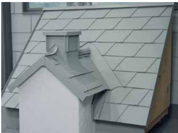
Einbindung Satteldach ins Hauptdach
